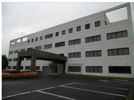
エントリー外観
